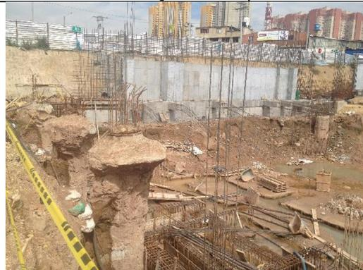
Muro de contención y pilotes zona de tramoya
